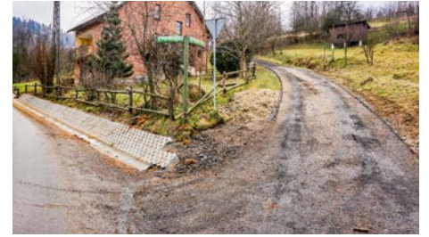
Gmina Świnna: utwardzenie drogi w Przytękowie
