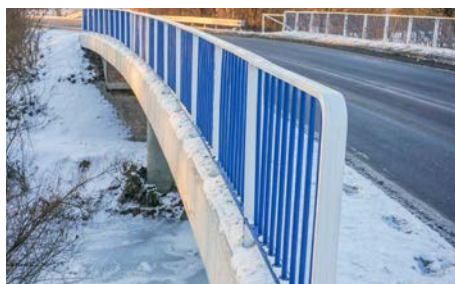
Gmina Łękawica: remont gzymsu na moście w Łękawicy
