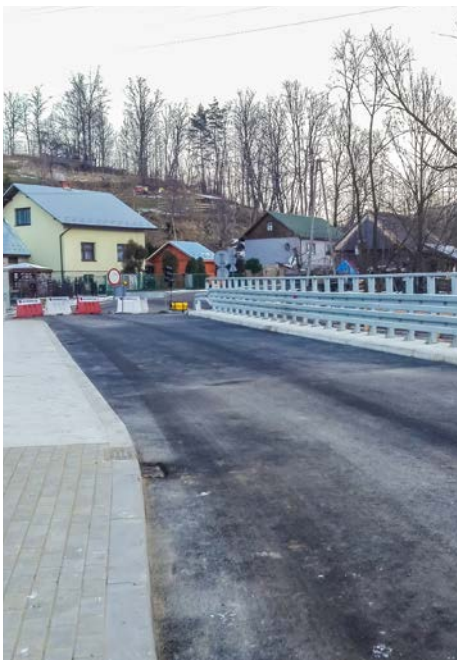
Gmina Radziechowy-Wieprz: budowa obiektu mostowego w Juszczynie
