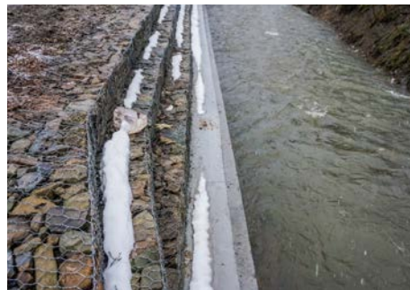
Gmina Rajcza: wykonanie muru oporowego w Rycerce Górnej
