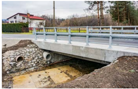
Gmina Gilowice: remont obiektu mostowego w Gilowicach
