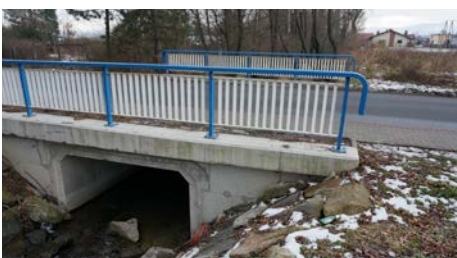
Gmina Łodygowice: remont przepustu na ul. Kasztanowej
