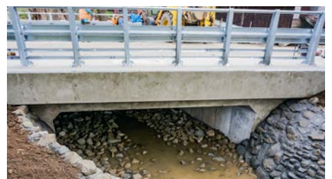
Gmina Łodygowice: remont obiektu mostowego w Biernej
