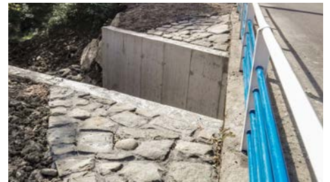
Gmina Jeleśnia: remont obiektu mostowego w Pewli Wielkiej
