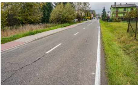
Gmina Łękawica: oznakowanie poziome dróg
