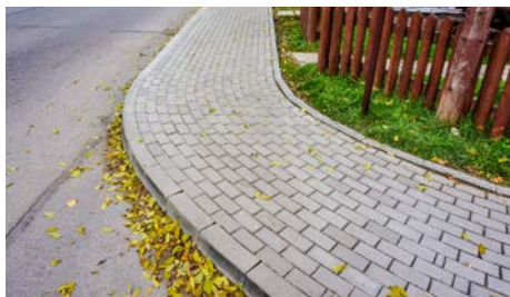
Gmina Ujsoty: remont chodnika
