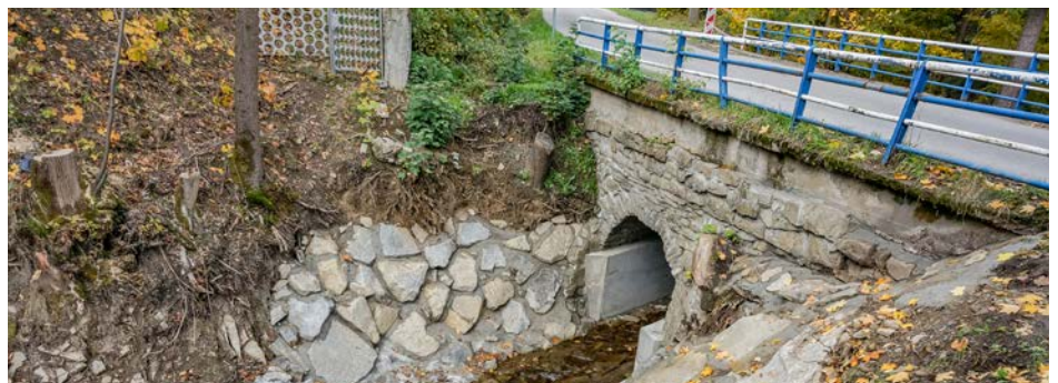
Gmina Radziechowy-Wieprz: remont obiektu mostowego w Bystrej
