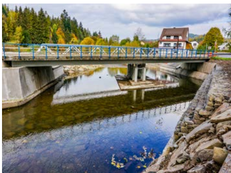
Gmina Ujsoty: remont przyczółków mostu - okolice skrzyżowania na Sobólówce
