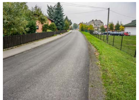
Gmina Lipowa: remont drogi w Lipowej
