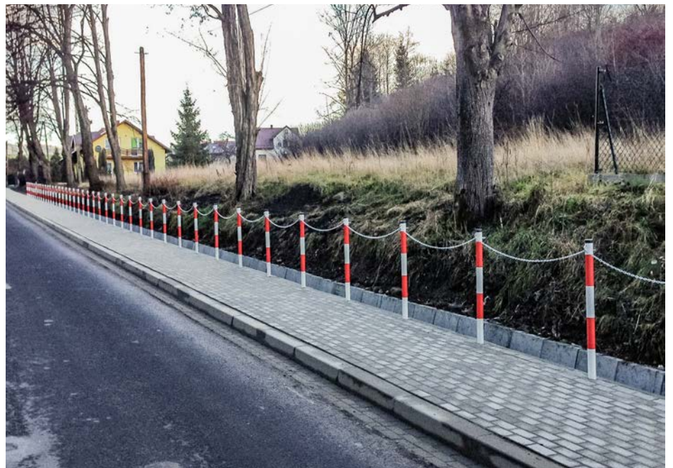
Gmina Węgierska Górka: budowa chodnika w Cięcinie
