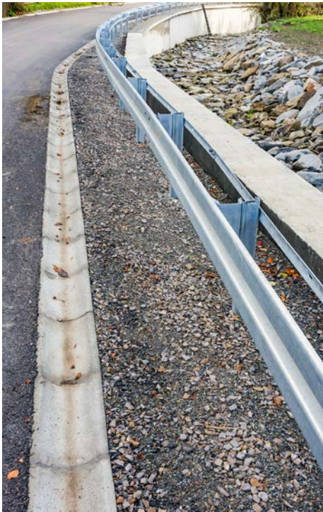
Gmina Milówka: zabezpieczenie koryta potoku w Prusowie
