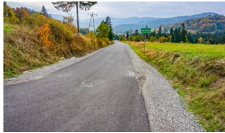
Gmina Rajcza: remont drogi Sól-Nieledwia
