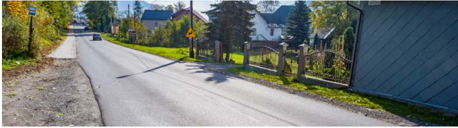
Gmina Milówka: remont drogi powiatowej Milówka-Rajcza
