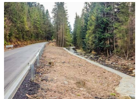
Gmina Węgierska Górka: wykonanie muru oporowego w Żabnicy
