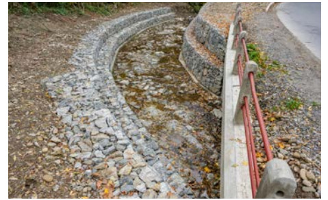
Gmina Gilowice: zabezpieczenie koryta potoku przy moście w Rychwałdzie
