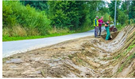
Gmina Ślemień: udrożnienie odwodnienia w Koconiu
