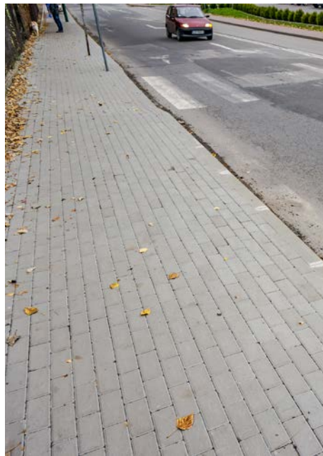
Miasto Żywiec: remont chodnika, ul. Komornieckiego
