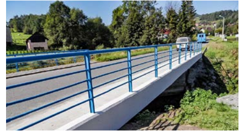
Gmina Milówka: remont obiektu mostowego w Kamesznicy – okolice szkoły
