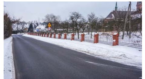
Gmina Lipowa: remont drogi powiatowej pomiędzy kościołem a szkołą w Lipowej
