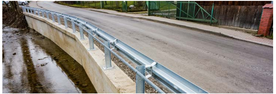
Gmina Świnna: zabezpieczenie koryta potoku przy Urzędzie Gminy w Świnnej
