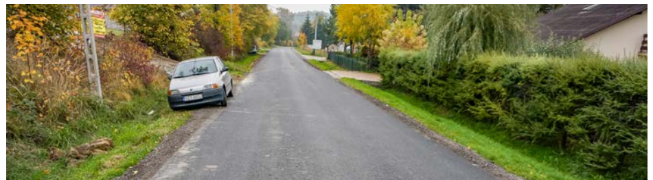
Gmina Radziechowy-Wieprz: remont drogi na Wajdówkę
